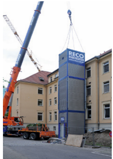
Der Aufzug steht! (Fotos: Melitta Dybiona)
